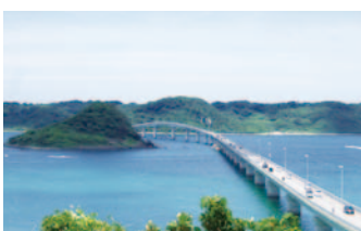
下関市・角島大橋
